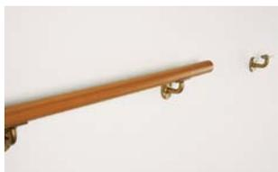
ブラケットを取付け、手すり棒をブラケットに仮置きし、長さを調整します。
